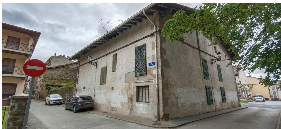
Imagen de parcela con edificación principal y anexos desde su orientación este.
